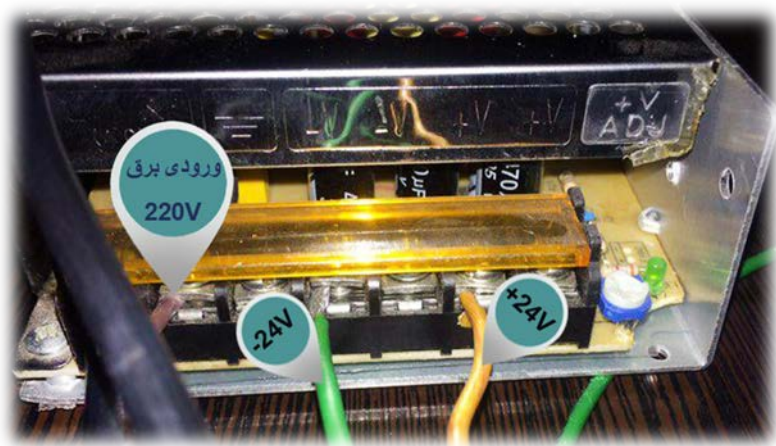
تصویر شماره ۳ (نصب منبع تغذیه)
